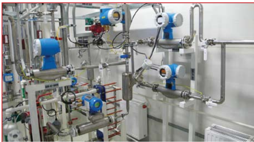
Рис. 2. Размещение расходомеров по точкам учета
